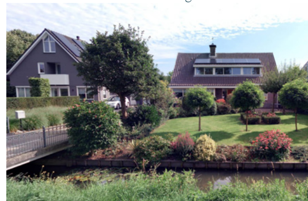
Zonnepanelen afgestemd op dakvlak
